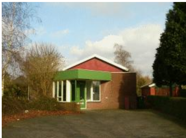
Na de verbouwing
